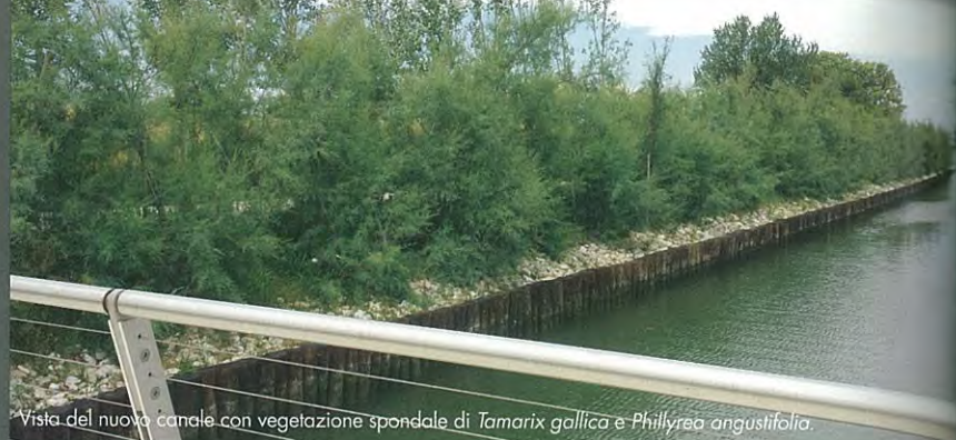
Fase dei lavori del canale.
