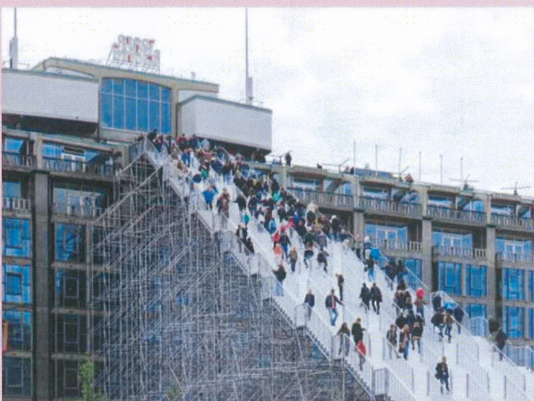
Das Büro MVRDV hat 2016 eine temporäre Treppe für das Dach eines großen Gebäudes in Rotterdam konstruiert
